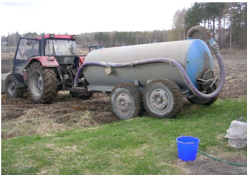
Kuva 2. Maataloudessa käytettävä imupainevaunu soveltuu hyvin kalkkistabiloinnin suorittamiseen
