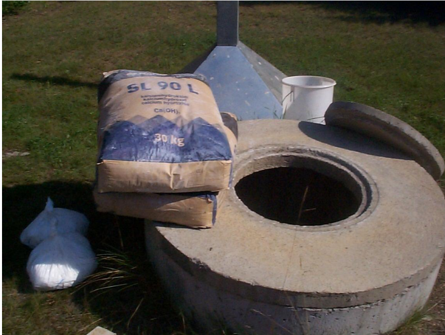
Kuva 1. Varaa kalkkistabilointia varten riittävä määrä sammutettua kalkkia
